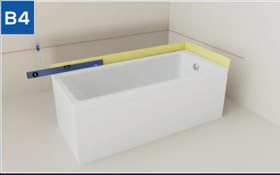
Mittels Wasserwaage oder Laser die Oberkante der Wanne an der Wand anzeichnen.
