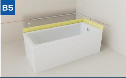
Selbstklebendes Schallschutzband auf Höhe der Wannenkante an der Wand anbringen.
