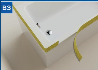
Wannen-Dichtbänder an den zur Wand gerichteten Außenkanten der Wanne anbringen.
