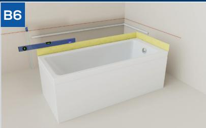
Mittels Wasserwaage oder Laser die Oberkante des Wannendichtbandes an der Wand anzeichnen.
